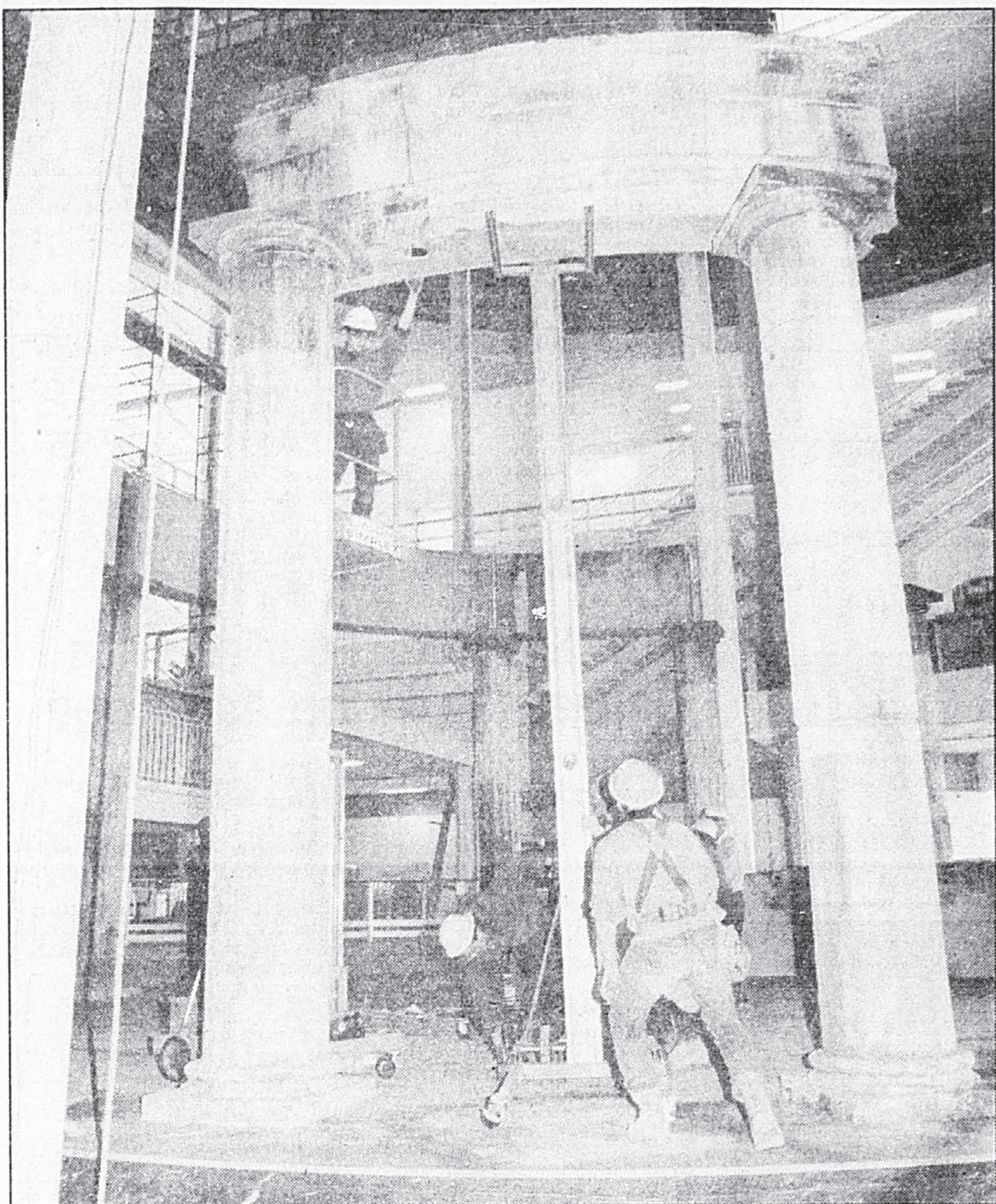
Les ouvriers montaient hier les fausses colonnes d'un Temple des Vestales, édifié au centre du bassin qui a retrouvé sa place au «niveau lagune» de l'ancien Pavillon de la France à l'Expo 67. Le décor réalisé par la firme montréalaise Le Pinceau d'Arlequin, abritera une version moderne au gaz naturel, de la «flamme éternelle» qui brûlait au cœur de la Rome antique, qui sera à l'honneur du 8 mai au 27 septembre, au Pavillon de la Civilisation de l'île Notre-Dame.
